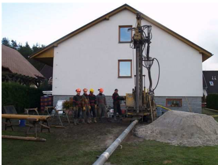
Obrázek č.13 – Provedení vrtu vedle rodinného domu
