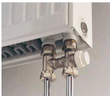
Regulační šroubení – přímé (Ventil kompakt)
