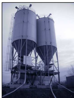
Obr. č. 2 – Silo na popílek
