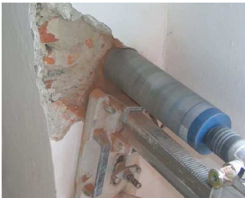
obr. č. 4.1 - Způsob odběru jádrového vývrtu ze zděné konstrukce [16]
