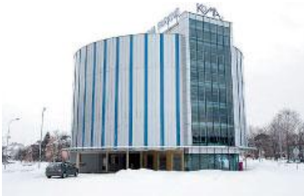
Obr. 1.1 Realizace parkovacího domu Ostrava - Svinov
