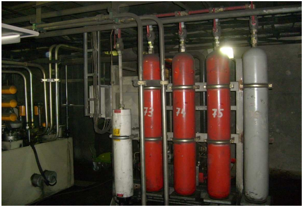
Obr. 3.4 Pístový akumulátor
