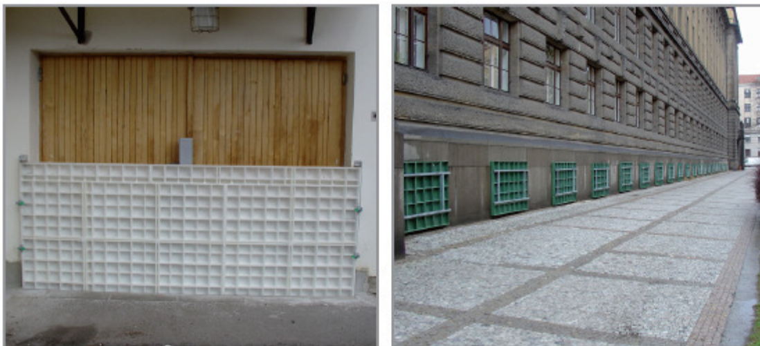
Obrázek 4: Ochrana pláště ocelové, plastové pláty [24]
