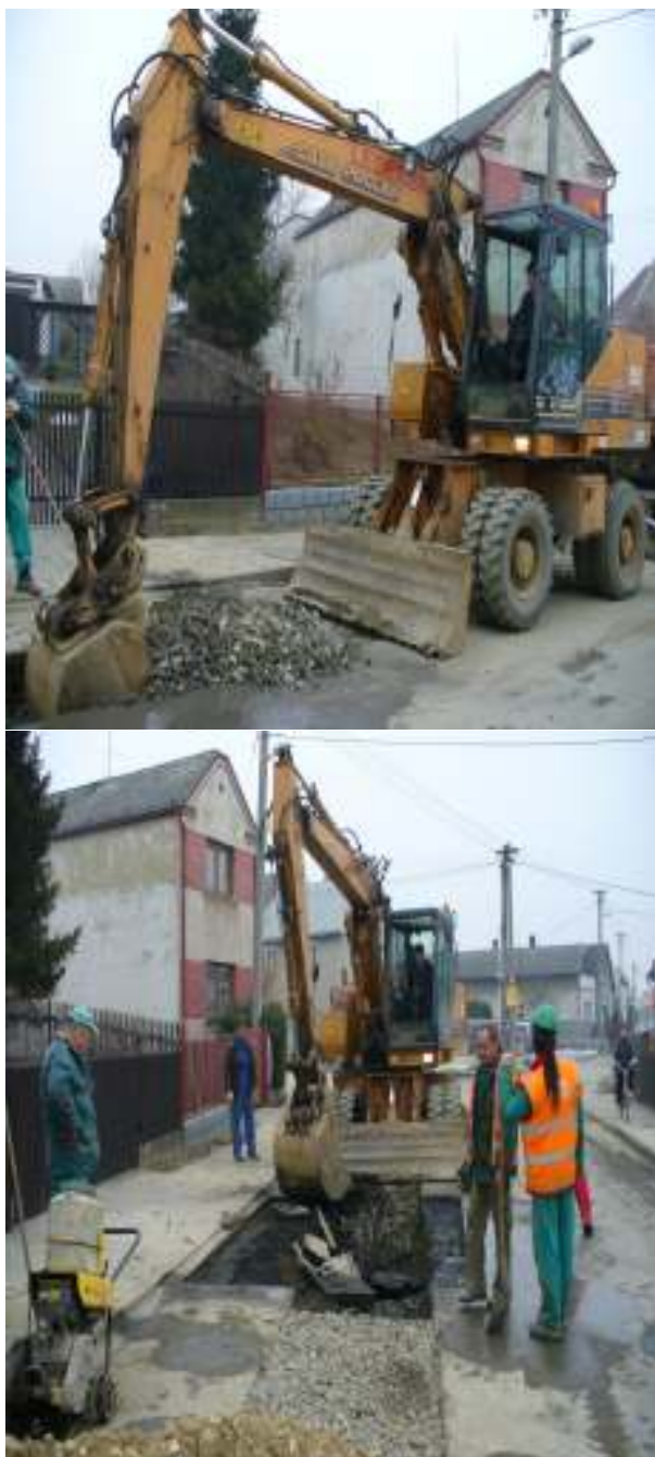
Obrázek č. 4: Práce na staveništi s použitím kolového rypadla CASE 788 P2AL [5]
