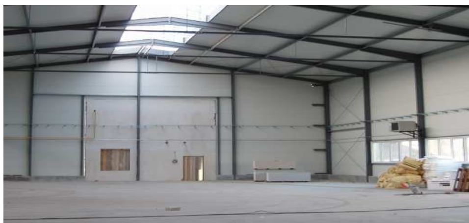
Obr.27 Vnitřní pohled do skladu svitků plechů a jeho polotovarů.
