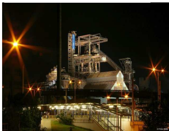
Obr. 4.16 Areál dolní oblasti Vítkovice v Ostravě
