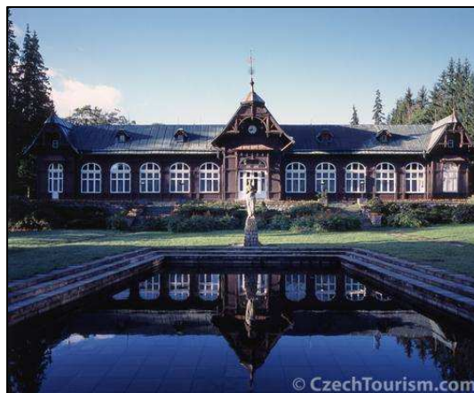
Obr. 4.21 Lázeňské budovy v Karlově Studánce
