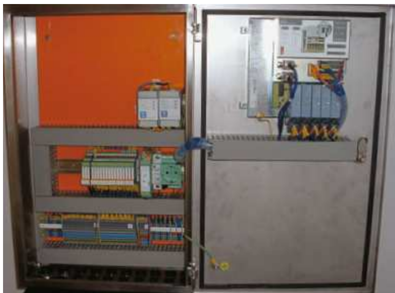
Obr.15 - Měřicí ústředna systému F-LINK
