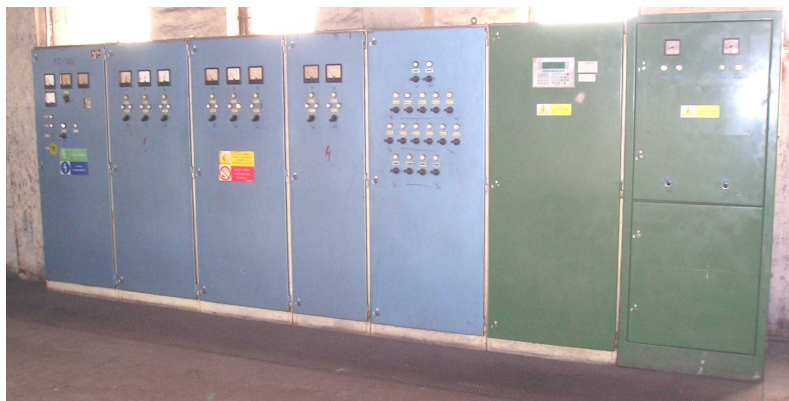
Obr. 20 Elektrický rozváděč
