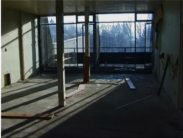
Obr.9: Sloupy lehké nosné ocelové konstrukce (klubovna v hotelové části).
