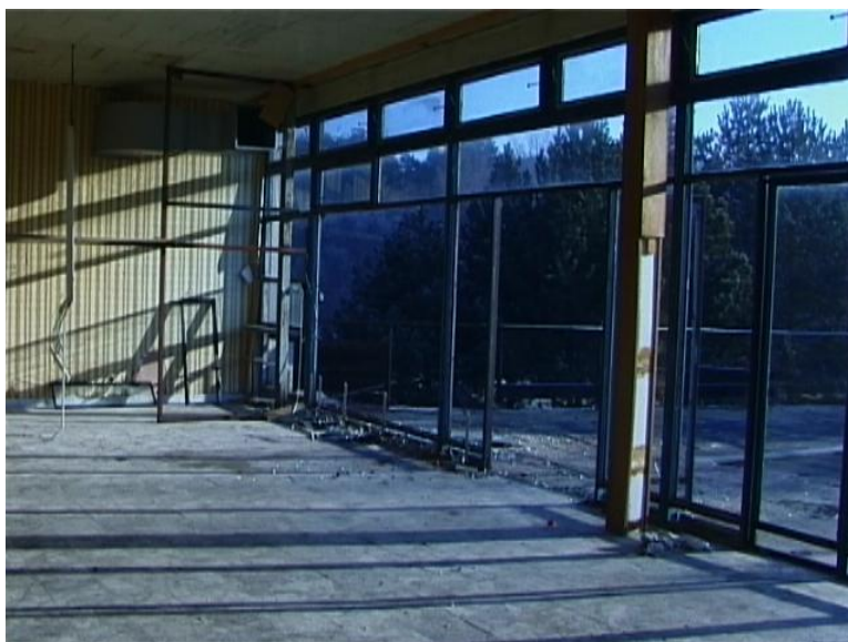
Obr.11: Prostor jídelny – čelní prosklená stěna
