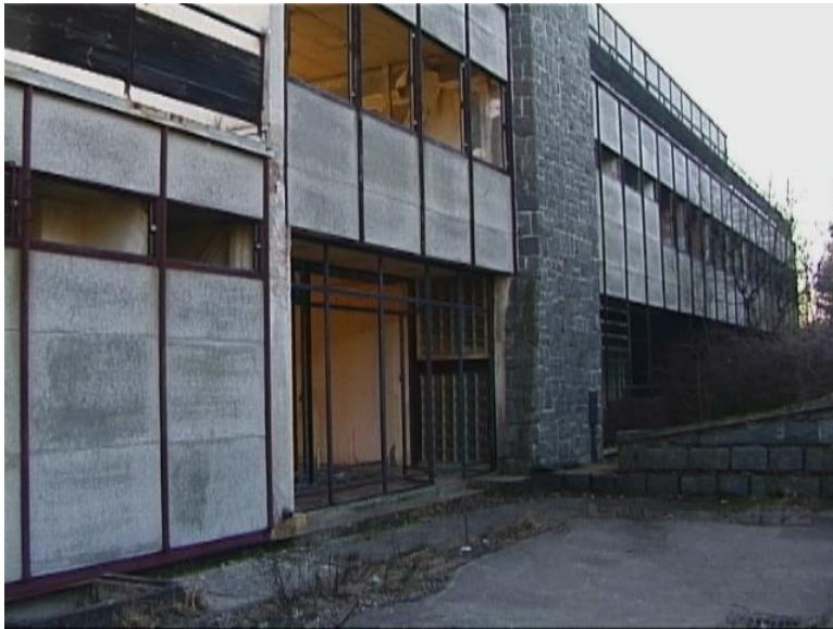
Obr.4: Frontální fasáda – vlevo hotelová část, vpravo provozní budova, střed – schodišťový prostor
