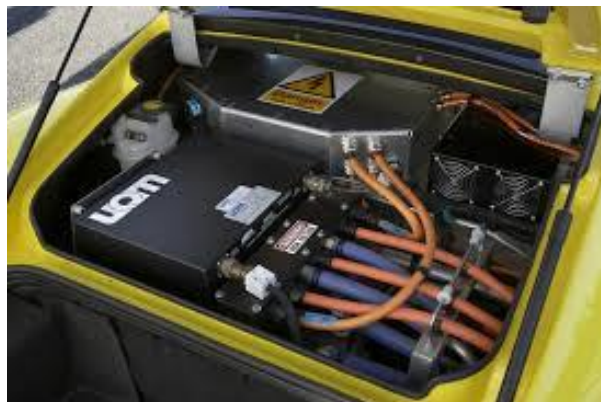
Figura 1.2: batteria di alimentazione veicolo elettrico (Dodge).
