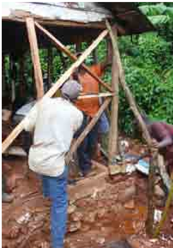
Ci-dessous, chantier formation à Cap Rouge, reprise et renforcement de l'existant
