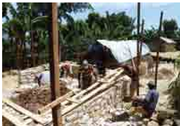
Ci-dessus, un chaînage bois horizontal est disposé tous les 65 cm de haut
