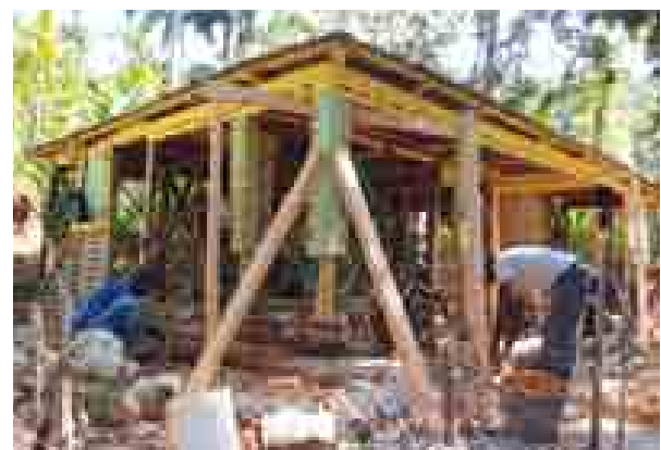
Maison Joseph Dieujuste, zone de Coupeau située à 6 heures de marche de la ville de Carrefour. Réparation et amélioration de sa maison. Étayage de la maison, sciage des poteaux et construction du soubassement en pierre
