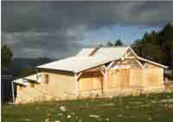
Centre de GADRU à Belot, construit en chantier formation, selon la même technique que les amorces de maisons.
