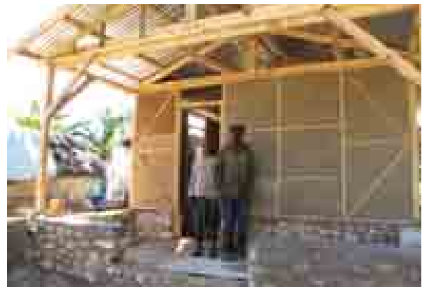
Ci-dessous, exemples de maisons à ossature bois et remplissage en briques de terre moulée
