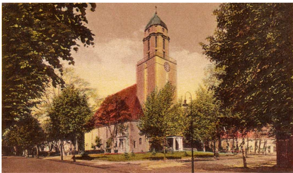
Rys. 1. Widok kościoła z roku 1936 od strony ul. Niepodległości, dawniej Bahnhofstrasse ( www.dolny-slask.org.pl )
