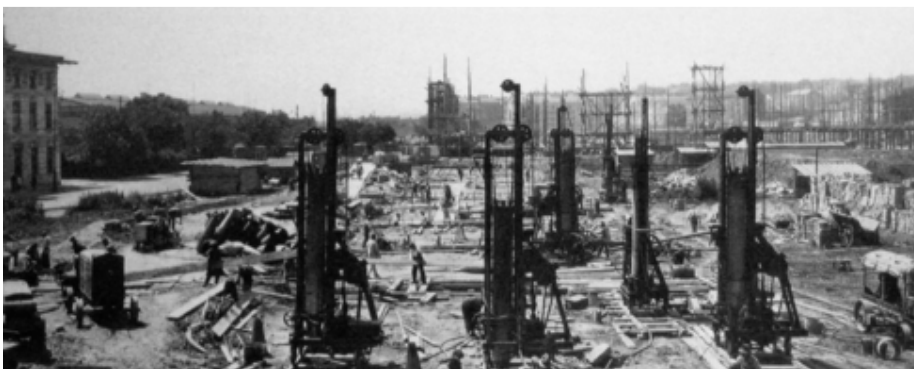
Imagem 3: Construção do Karl Marx-Hof em Viena entre os anos de 1926 a 1933.
