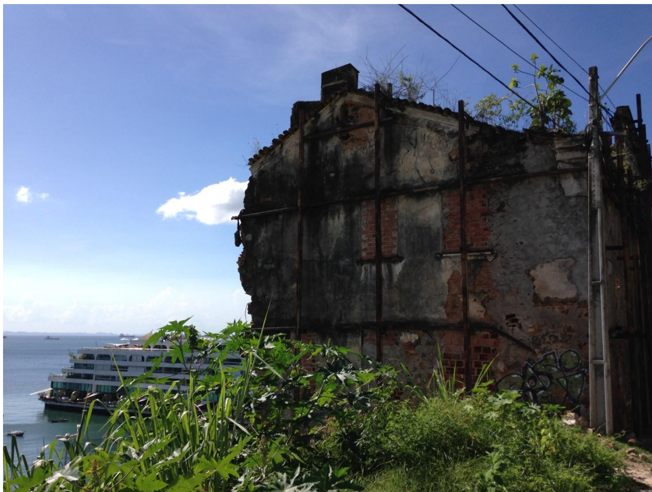
Figura 1: Empreendimento habitacional de luxo visto de edificação em ruína no centro antigo de Salvador (Carreira, 2017)
