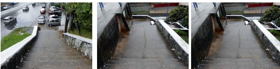
Figura 14: Vistas da escadaria de acesso à Rua Frederico Costa (Barbosa, 2015)
