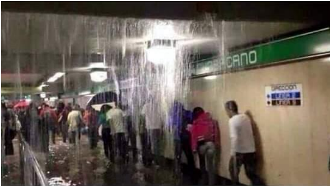
Título: Riesgos por inundación en estación subterránea. Imagen propiedad de: Imagen Radio. Agosto de 2016.
