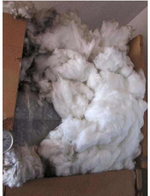
Imatge 1: Dipòsit acumulador actual
