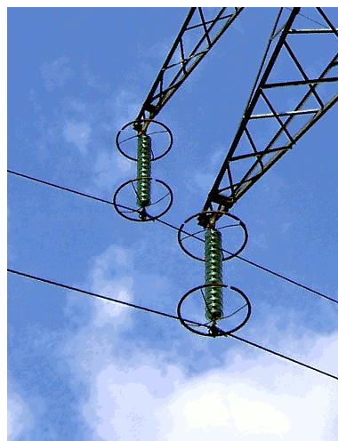
Figura 4-2 Anells Anticorona juntament amb la cadena d'aïlladors, en suspensió.
