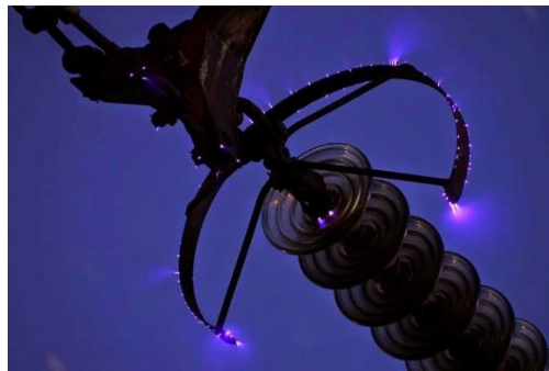
Figura 4-1 Anell Anticorona juntament amb la cadena d'aïlladors, en amarre.
