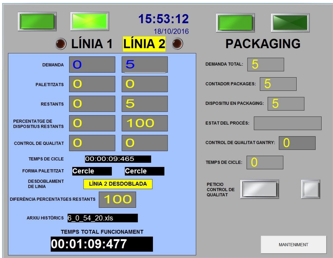
Figura 95: SCADA-Paletitzat amb desdoblament de línia 2
