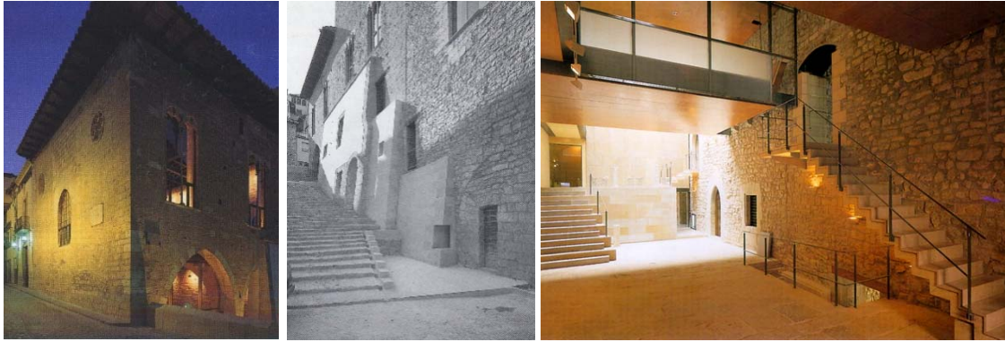
Fig. 2-3-4. Imágenes del edificio rehabilitado 1997
