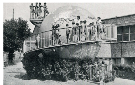
Imagen 01_École de plein-air, Suresnes _ 1932-1935, Eugène Beaudouin et Marcel Lods
