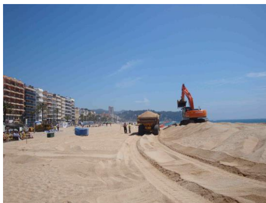
Figura 40. Operacions de redistribució de sorra a la platja de Lloret (Departament de Medi Ambient de Lloret de Mar)
