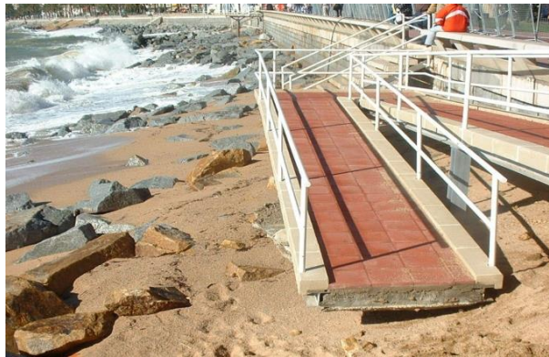
Figura 10. Efectes sobre les rampes d'accés durant el temporal d'octubre del 2003 (Departament de Medi Ambient de Lloret de Mar)
