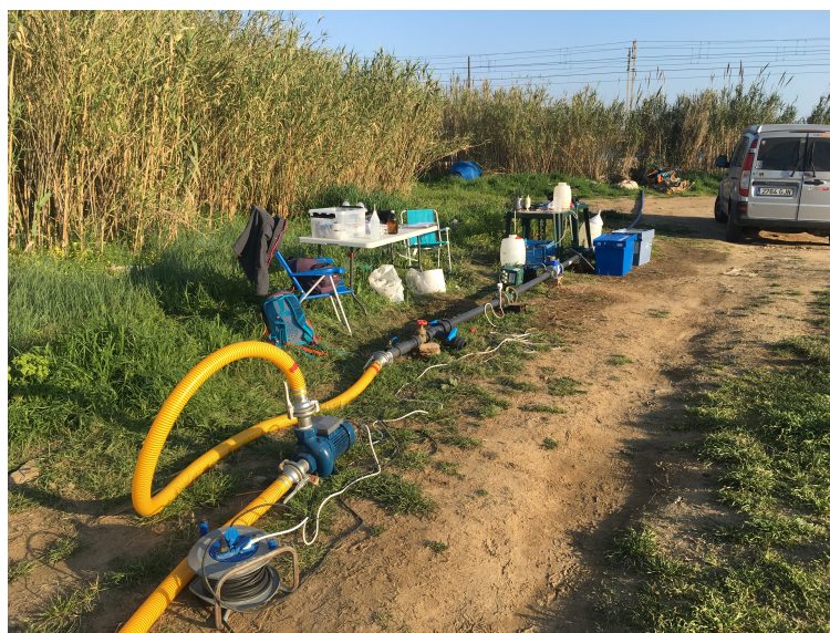
Figura 3.5.- Fotografia de la instal·lació de l'assaig de bombeig.
