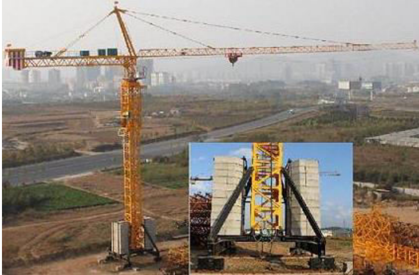
Imagen 3, torre grúa desplazable sobre railes de Yantai Haishan.
