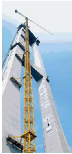
Imagen 7, grúa torre trepadora instalada apoyada sobre la misma obra.
