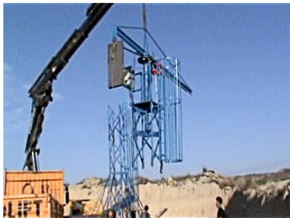
Imagen 4, foto durante el montaje de una grúa torre desmontable.
