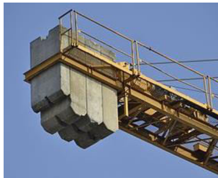
Imagen 17, contrapluma con contrapesos montados.
