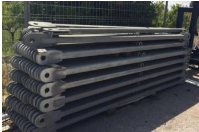
Imagen 27, Tirante desmontado formado por barras unidas mediante bulones.
