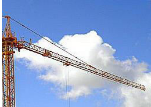
Imagen 15, pluma de una grúa torre.
