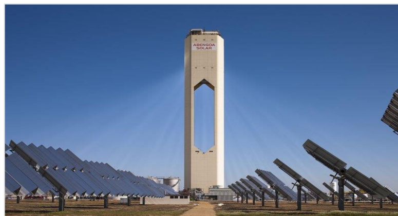
Figura 5.6 Concentrador central de Torre y helióstatos. [41]
