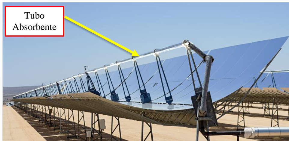
Figura 5.20 Ubicación tubo absorbente en Colector Cilíndrico Parabólico. Adaptado de [49]
