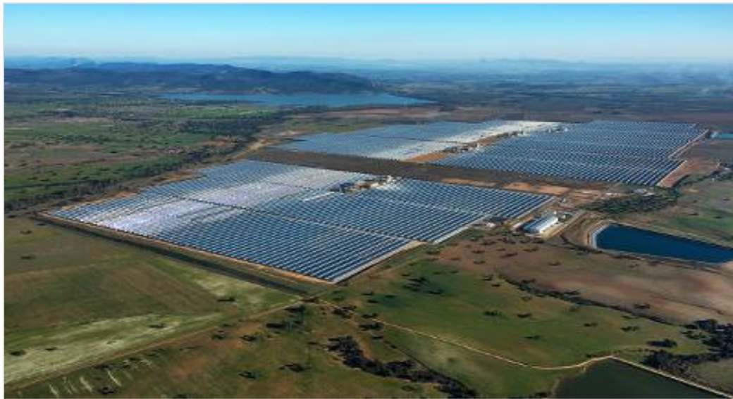
Figura 5.11 Plataforma solar de Extremadura Solaben. [44]
