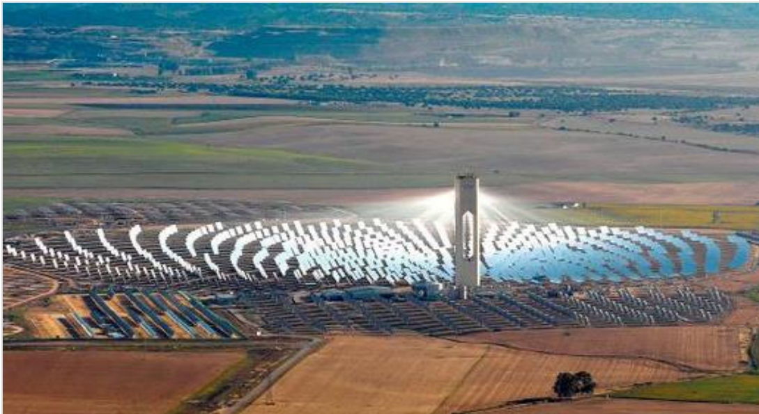
Figura 1.1 Central termosolar de tipo Torre. [43]
