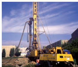
Equip de perforació d'un sondeig
