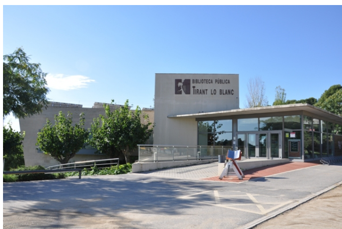
Fig. 5.7: Fachada de la biblioteca dónde se instalaran instalara los sistemas de flexibilidad energética del proyecto REFER para edificios terciarios.
