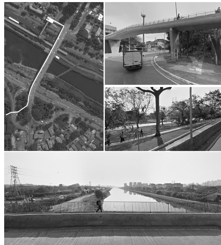
Figura 9. Transposición Marginal Pinheiros a partir de la estación de tren Cidade Universitária; Accesos peatonales al viaducto de los dos lados de la marginal Pinheiros; Viaducto sobre el río Pinheiros. Fuente: Elaboración propia, Google Maps
