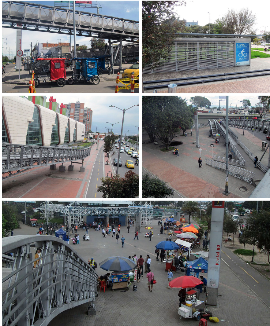
Figura 6. Funciones del puente peatonal. Como instrumento para la movilidad: Parada informal de taxis y bicitaxis (Estación Cardío Infantil), Cicloparqueaderos (Estación Alcalá); Como medio de conexión de fronteras urbanas (Centro Comercial Titán); Como medio de apropiación de lo público. Fuente: D. Barbosa, S. Rodríguez
