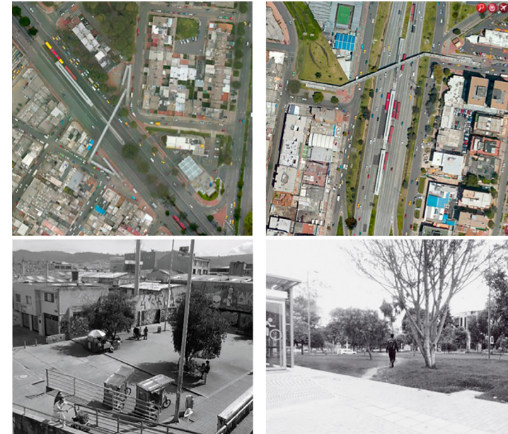
Figura 8. Puente Peatonal Estación Polo (Calle 80) y plazoletas construidas a partir de la demolición, para el desarrollo de los puentes peatonales. Medianeras sin resolver y aparición de grafitis; Puente Peatonal Estación Calle 27 (Autopista Norte) y entrega de puente peatonal hacia parques y sector residencial. Fuente: Mapas Bogotá, D. Barbosa, S. Rodríguez
