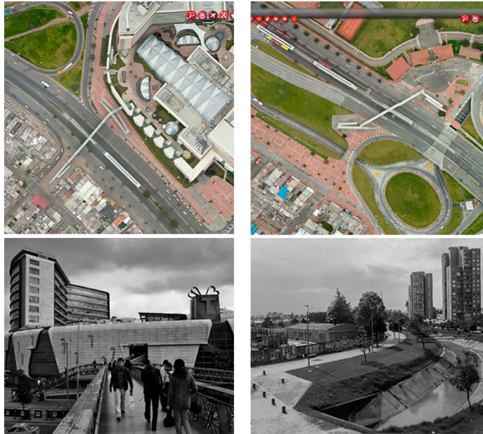
Figura 9. Puente Peatonal Estación Boyacá (Calle 80) y acceso directo del puente peatonal al segundo nivel del Centro Comercial; Puente Peatonal Estación Escuela Militar (Calle 80) y vista sobre el espacio residual producto de la inserción de infraestructuras. Fuente: Mapas Bogotá, D. Barbosa
