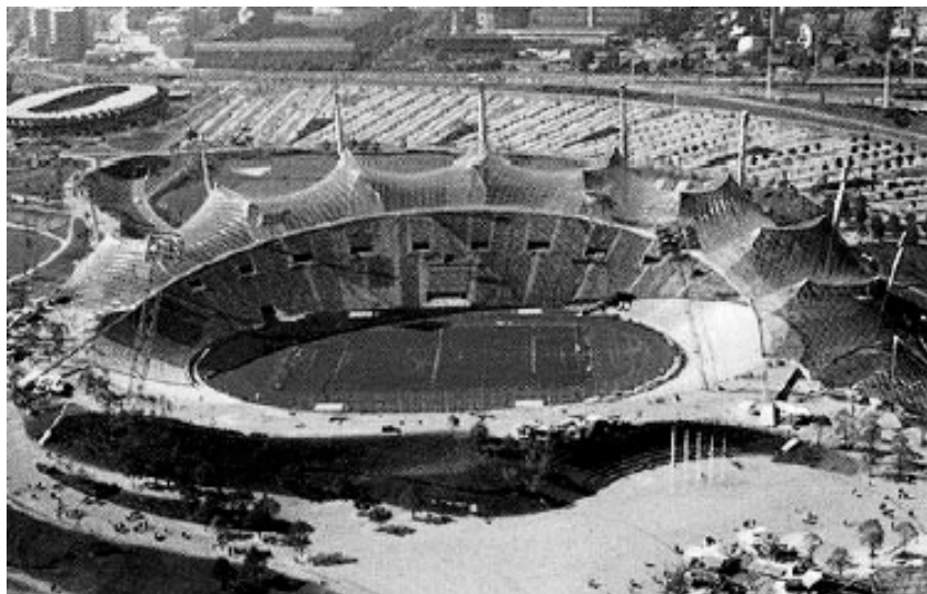
Figura 5.4. Cubiertas del Estadio Olímpico de Munich, reproducida de (Tibert, 1999).
