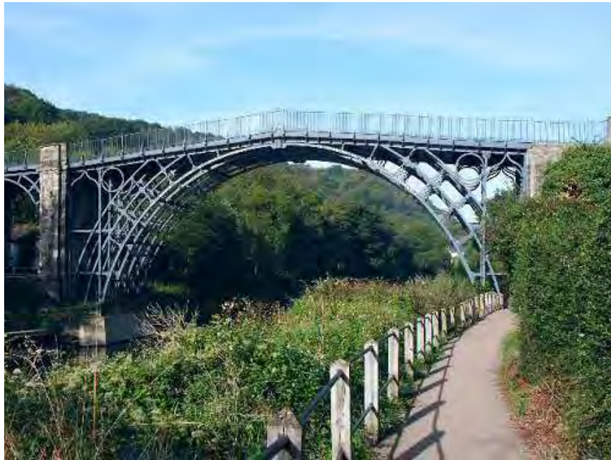
Figura 1.1. Primer puente metálico de la Historia (1777-1779), obra de Abraham Darby ( http://www.virtual-shropshire.co.uk )
