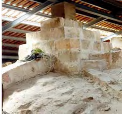
Figura 7.10 Macizos situados en las claves de las bóvedas
