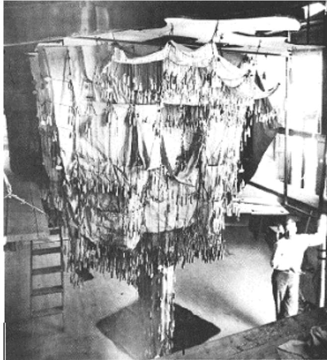
Figura 5.2. Maqueta antifunicular de la Colonia Güell
