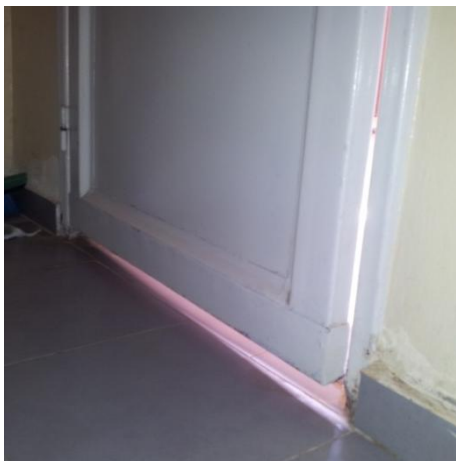
Fig.19: Les parts inferiors de les portes no acaben d'ajustar.
