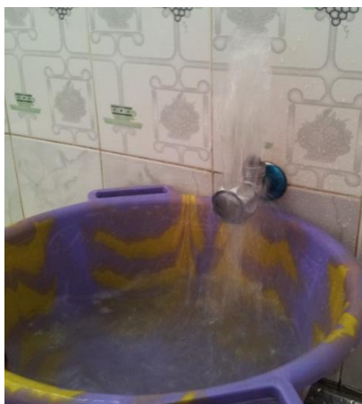
Fig.23: Aixeta trencada, sortida d'aigua en direcció vertical.
