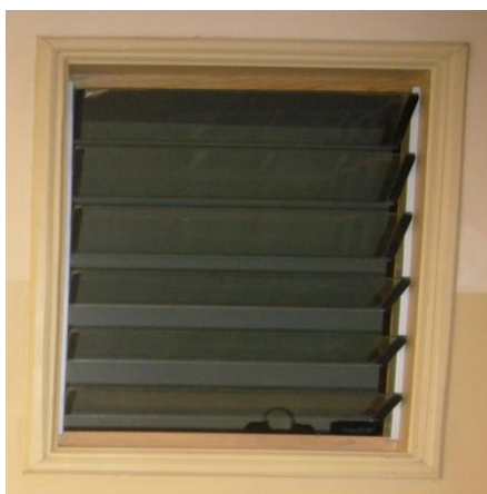
Fig.5: Finestra de vidre amb gelosia de panells giratoris.
