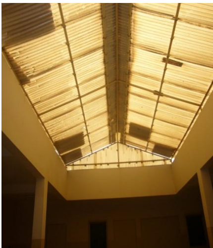
Fig.1: Claraboia protegida per una coberta de xapa ondulada de políester translúcida suportada per una estructura de ferro.
