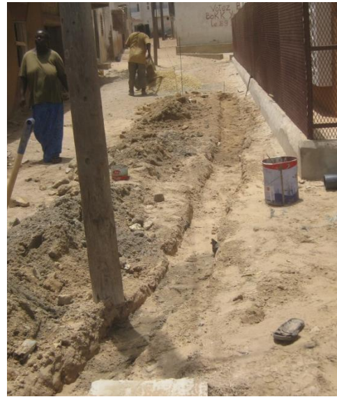
Fig.31: Construcció de la canalització soterrada per a la sortida de les aigües residuals del Centre. Font: Responsable del Centre.
