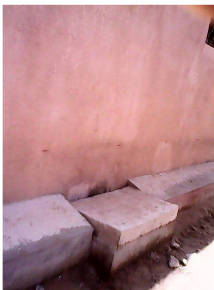
Fig.37: Accés/sortida de la fosa sèptica que comunica amb les latrines.
