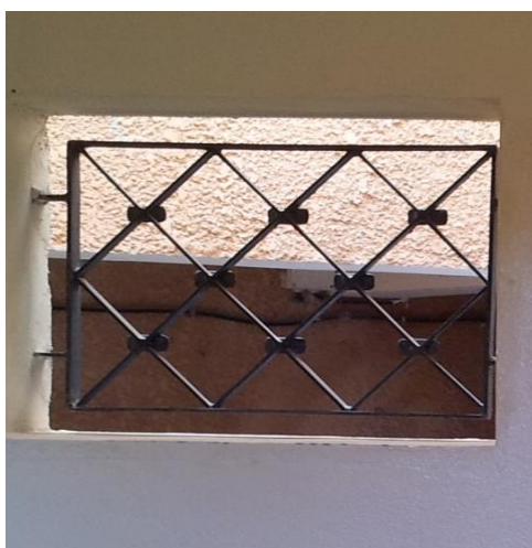
Fig.14: Reixes metàl·liques sense finestra (sala de bany 1).
