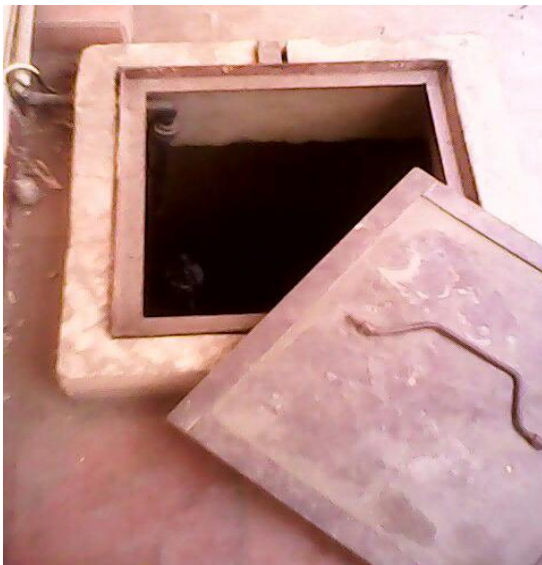
Fig.32: Cisterna que recull l'aigua de pluja (no potable).
