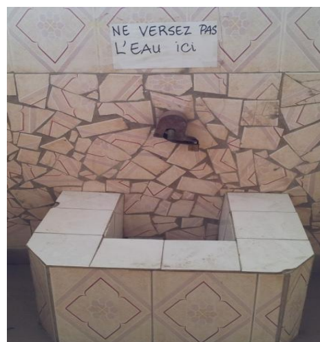
Fig.15: Pica d'obra enrajolada (sala de bany 1).
