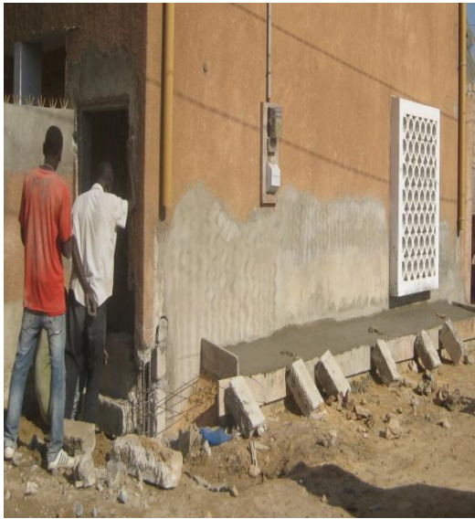
Fig.30: Construcció de la canalització del subministrament de l'aigua potable i de lavabos al Centre. Font: Responsable del Centre.
