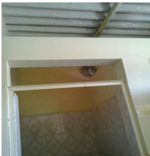
Fig.12: Sala de bany 1, on es veu la coberta del sostre.
