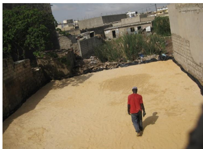
Fig.6: Compactació final del terreny abans de l'edificació. Font: responsable del Centre.
