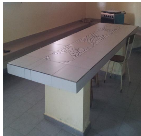
Fig.24: Taula d'obra on es manipulen els aliments. La superfície no llisa, fa difícil la neteja.
