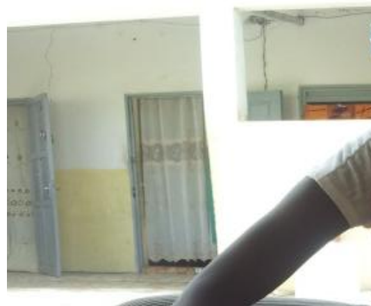
Fig.12: Comunicació dels diferents accessos de les cambres amb el pati de la casa.
