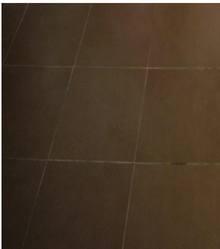
Fig.3: Paviment enrajolat de les habitacions contigües de la sala 2.
