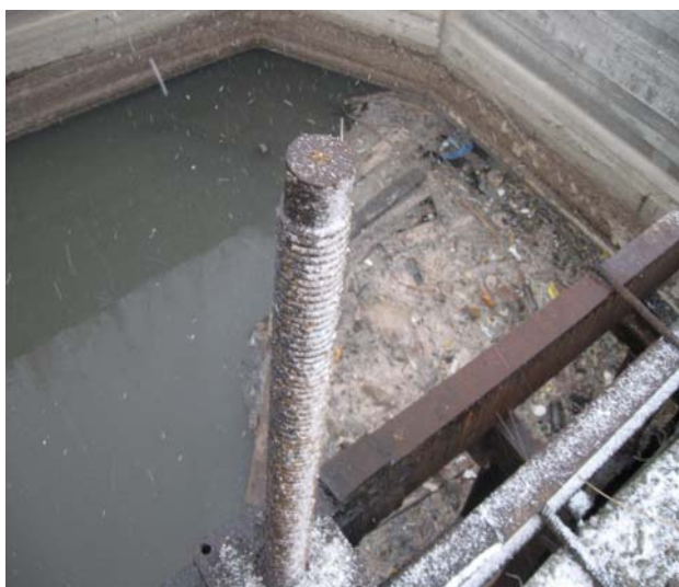
Рис. 4. Городская насосная станция (ГНС).
