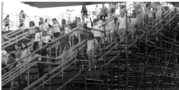
図5 仮設スタンド
