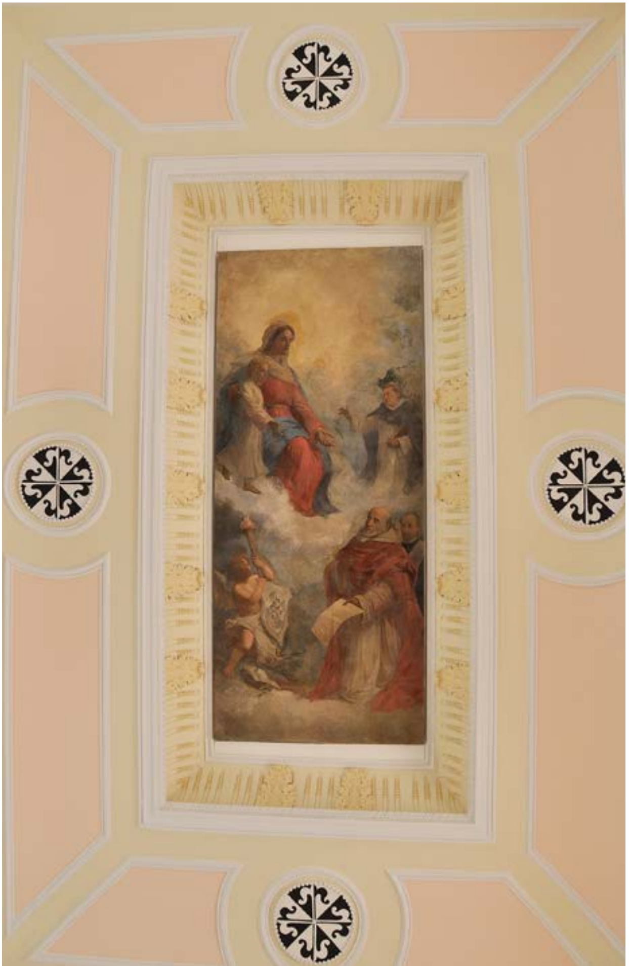
Detalle del techo de la escalera principal del Claustro.
