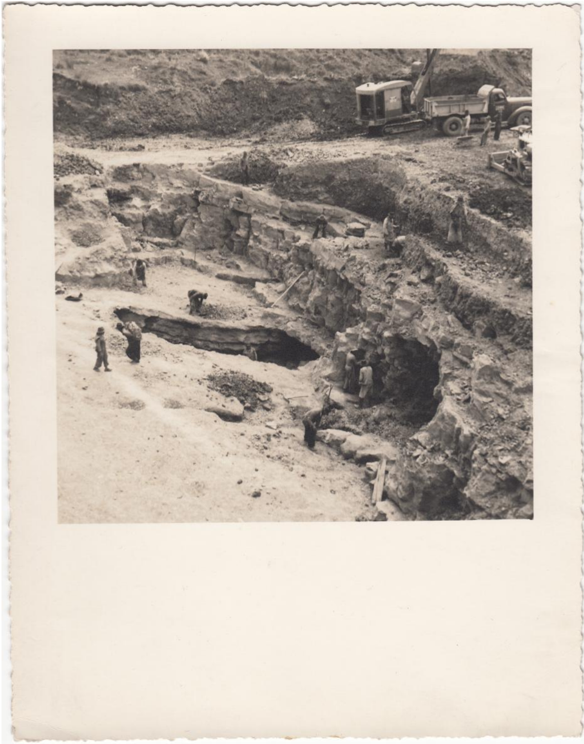
Mina de cal en el año 1955. Trabajadores partiendo y cargando la piedra caliza.
