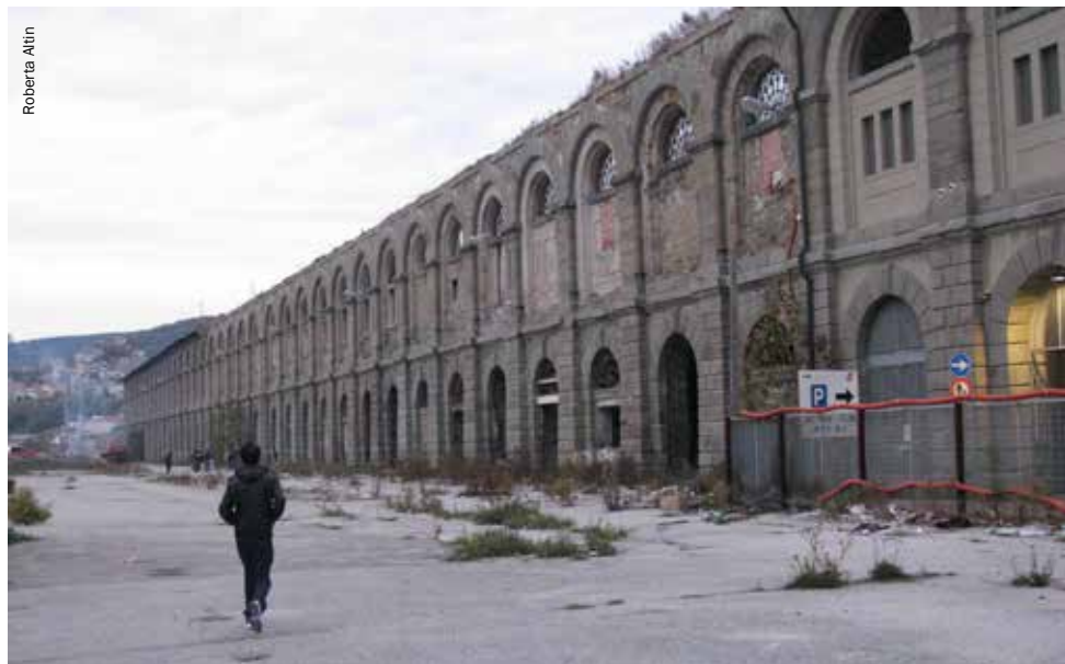
Silos, Trieste, Italia
