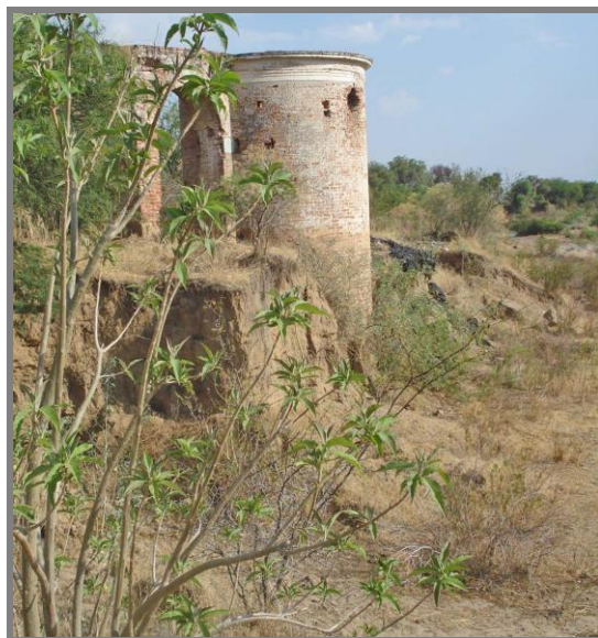
Fotografía 14. Profundización del cauce del río a un lado de una antigua noria en Chichimequillas. Fuente: propia.
