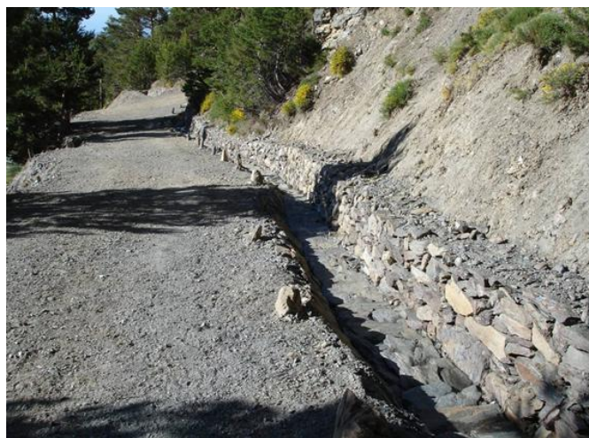
Figura 15. Restitución de un tramo de acequia de riego. Imagen del Parque Natural de Sierra Nevada.
