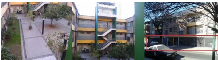
Imagen 27: Fotos de patio interno y cocheras de PB de Complejo Giribone 1330-PRTEXAu3. CABA. 2013
