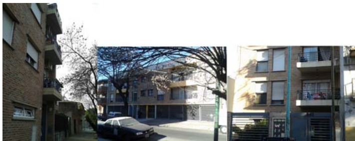
Imagen 29: Fotos de frente de hormigón y ladrillo descubierto en Complejos Estomba 1148, Giribone 1330 y Giribone 840. PRTEXAu3. CABA. 2013
