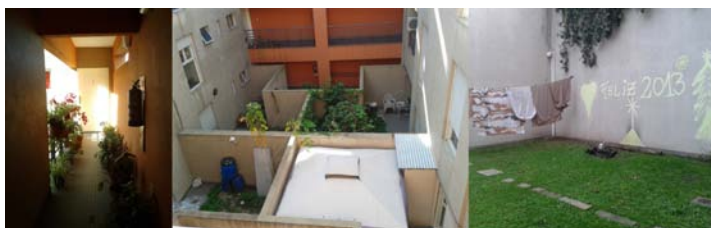
Imagen 18: Imagen de pasillos y patios internos de las viviendas de Estomba 1140, patio interno de vivienda de planta baja del Complejo Giribone 1330. CABA. 2013
