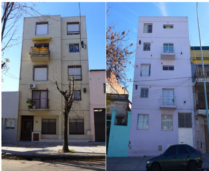
Imagen 8: Foto de fachada externa Coop. Luz y Progreso (doce familias) y Coop. 28 de Junio (diez familias). CABA. 2013
