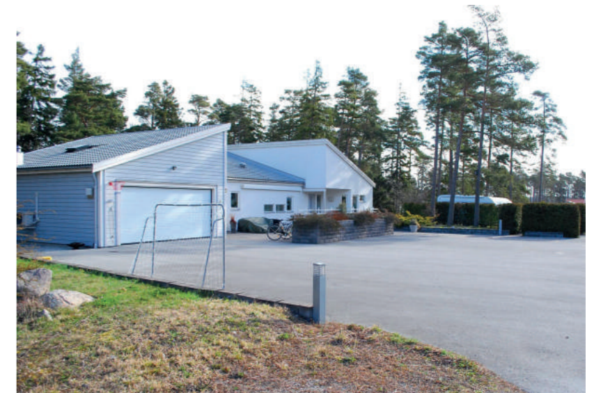
Bild på husets framsida.
