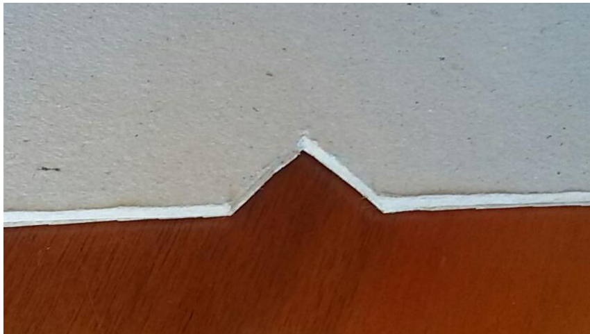
Fig. 7 - Tagli laterali alloggio dita
