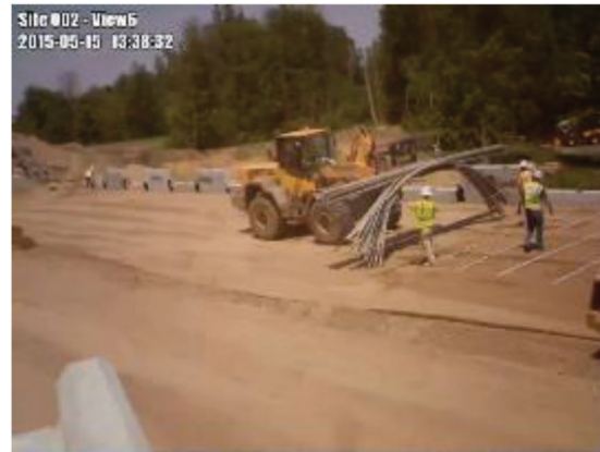
(d) Placing reinforcement straps
