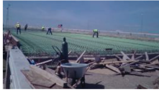
(d) 6/24/15 – Steel is placed on bridge
