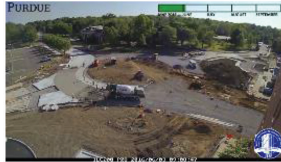
(d) Form up and place concrete pavement 6/7/16
