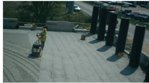
(d) 11:45 AM – Soil compaction
