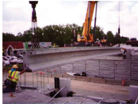
(d) Place concrete bridge beams 6/5/15
