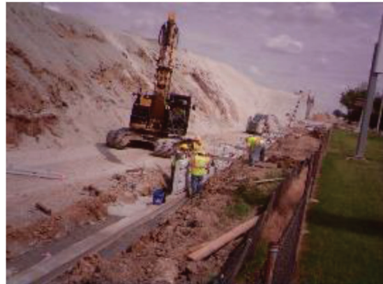
(d) Place temporary wood panel supports
