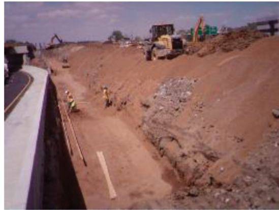
(d) Place pad wood forms
