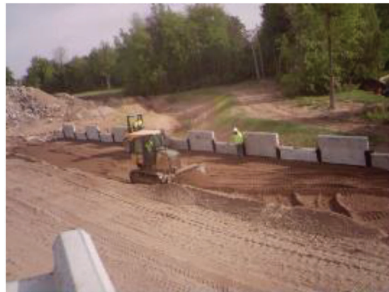
(d) Compaction begins, lift is complete
