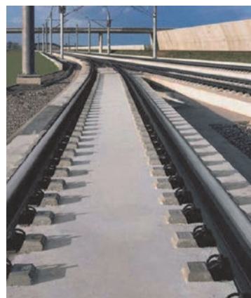
Slika 4. Kolosijek na čvrstoj podlozi Rheda 2000
