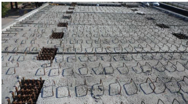
Slika 1. Primjena grupe moždanika u gradnji mostova
