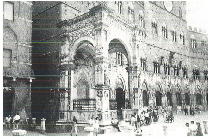
Fig. 16. Façade du palais communal : Cappella di Piazza.
