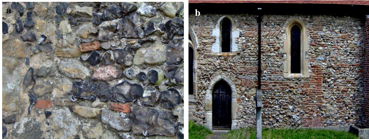
Figures 177 : mur nord de la nef de l'église Holy Trinity, de Milton Regis (Kent) : utilisation aléatoire et sporadique de la brique (a) (on voit également au centre de l'image un fragment d' opus signanum utilisé comme élément de remplissage) ; mur sud du chevet, White Notley (Essex) : utilisation préméditée de TCA dans les éléments architectoniques (b).
