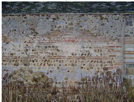
Figure 7 : Evocation d' opus spicatum sur le mur nord de la nef de Rugles, Normandie.
