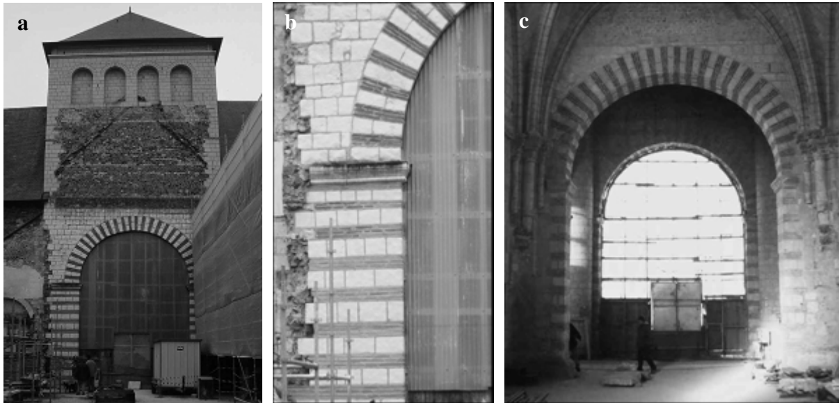
Figures 49 a, b & c : Vue de l'arc occidental de la croisée dans l'axe de la nef ; détail de la face externe du pilier nord ouest de la croisée ; vue de la croisée à partir du chœur (clichés CRP2A).
