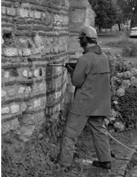
Figure 21 : Utilisation de la carotteuse lubrifiée à l'eau.
