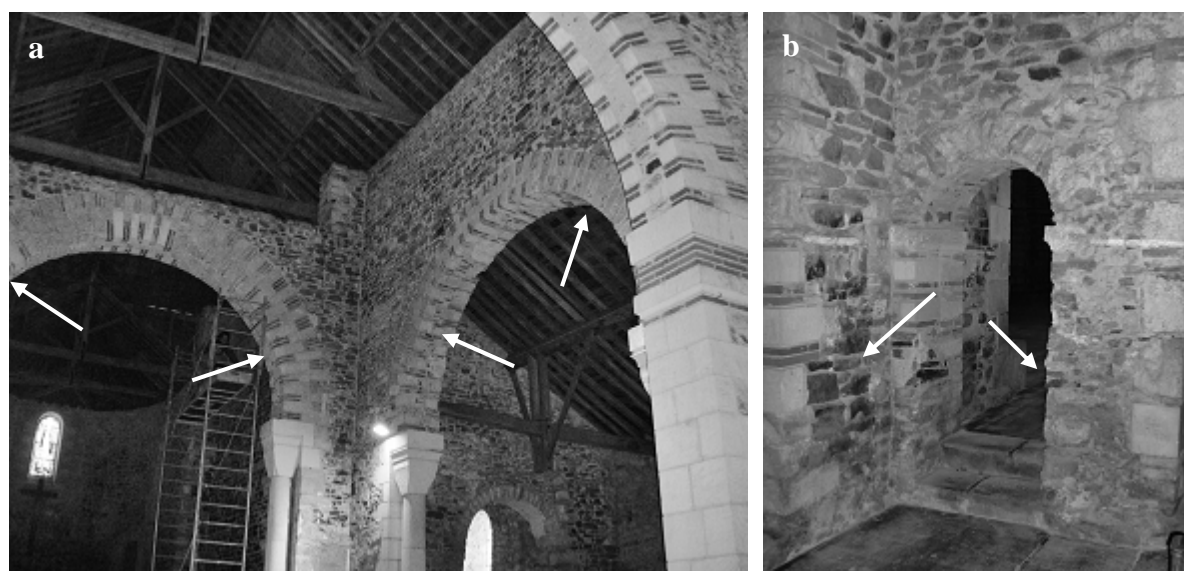
Figures 39 a & b : Vues de la croisée du transept et ouverture entre le croisillon nord et la chapelle nord du chœur (les flèches rouges indiquent les zones de prélèvements).
