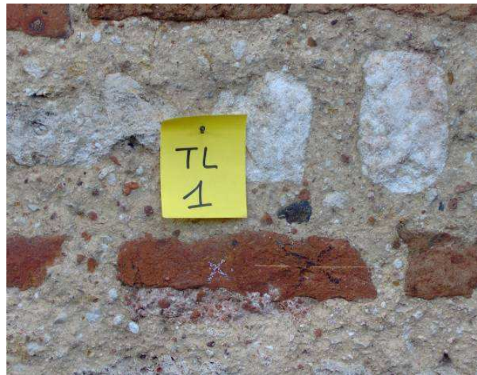
Figure 74 : Brique Bdx11979 / Dur346-3 avant prélèvement (on peut voir sur sa face inférieure des restes de béton hydraulique).
