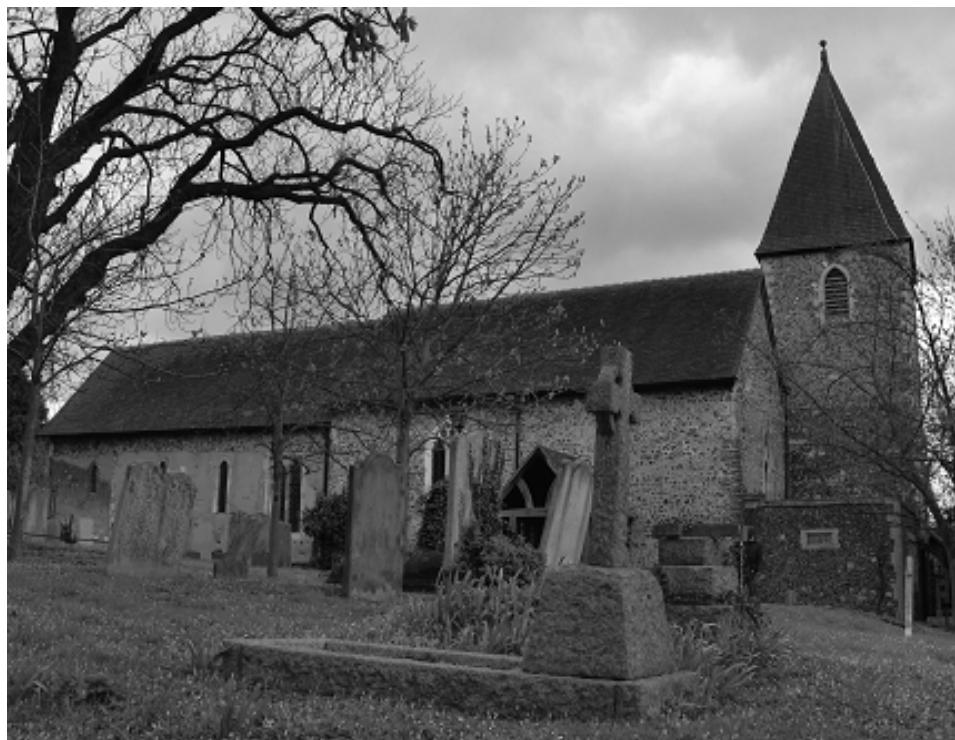
Figure 135: Eglise de Saint-Margaret, Darent (vue côté nord).
