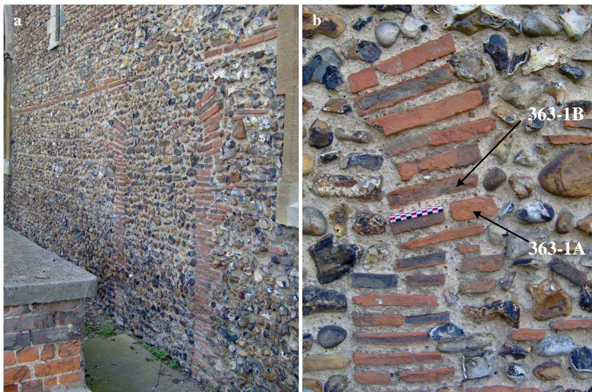
Figures 158 a & b : Localisation des prélèvements 363-1A et 363-1B : arc de l'ancien portail du mur nord de la nef.
