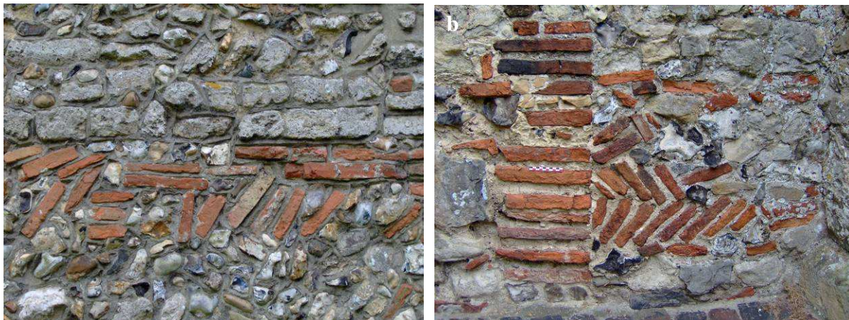
Figures 180: utilisation de TCA en opus spicatum dans la maçonnerie du mur nord de la nef, Colne Engaine (Essex) (a) et dans le mur sud du chevet de l’église de Lower Halstow (Kent) (c).
