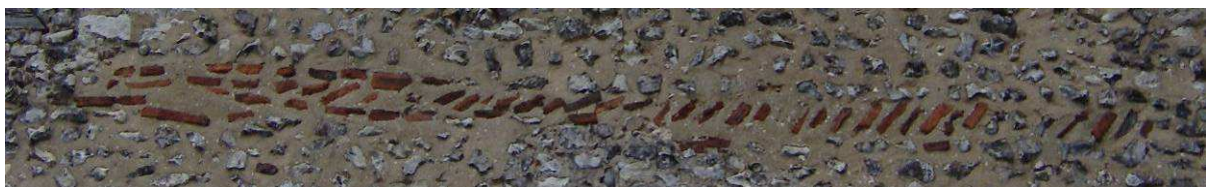
Figure 139: Détail du pan du mur occidental; évocation d'un opus spicatum .
