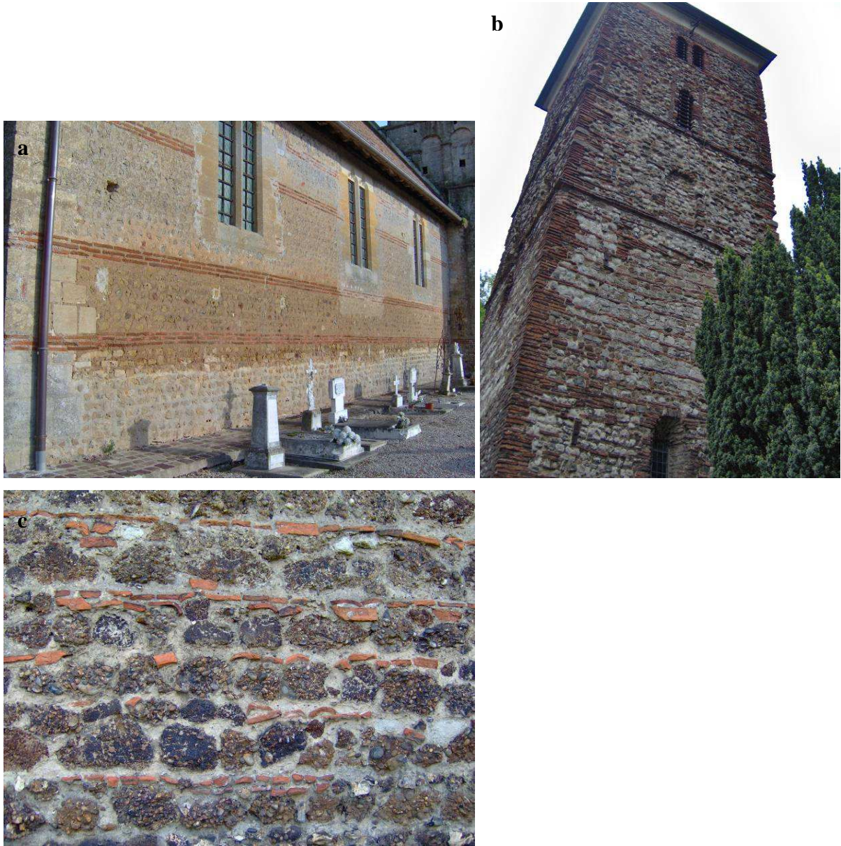
Figures 179 : briques utilisées en arases : mur sud de la nef, Vieux-Pont-en-Auge (Normandie) (a); mur sud de la tour d’Holy Trinity, Colchester (Essex) (b); mur nord de la nef d’Ingatestone (Essex) (c).
