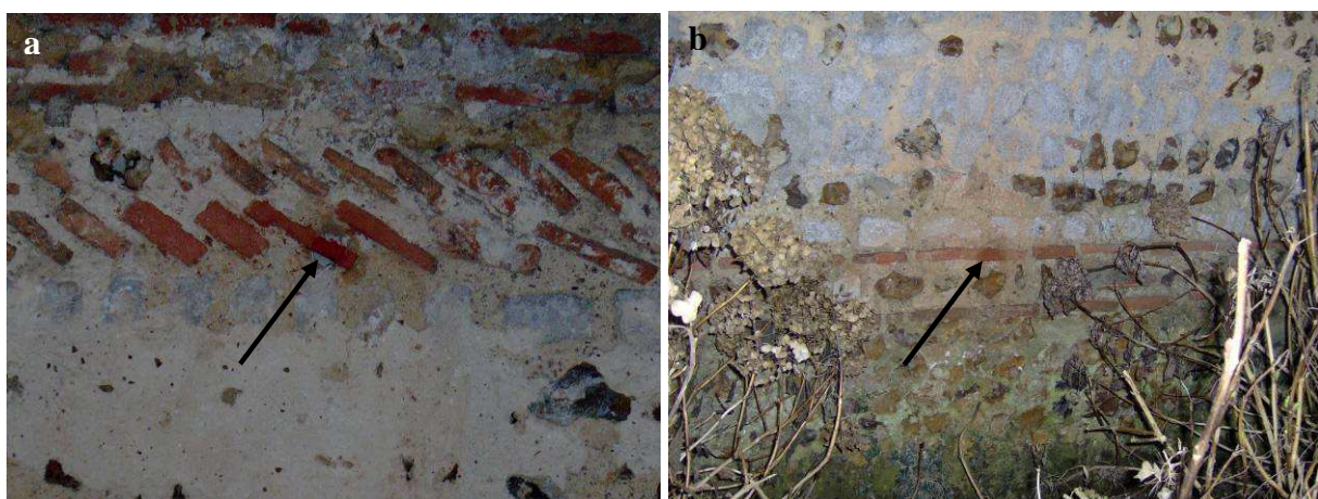
Figures 75 a & b : Vue des prélèvements Bdx11982/Dur346-1 (de l' opus spicatum ) et Bdx11983/Dur346-2, dans la partie inférieure du mur nord de la nef.
