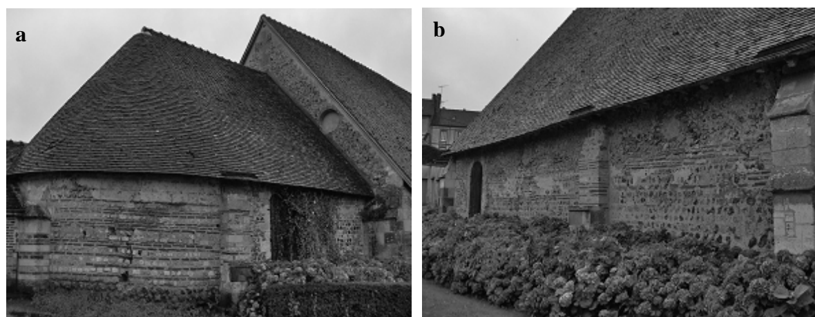
Figures 71 a & b : Vue du chevet, côté nord ; vue du mur nord de la nef.
