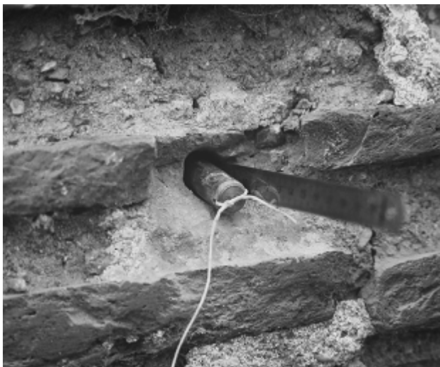
Figure 32: dosimètre placé dans le trou laissé par l'échantillon prélevé dans une brique.
