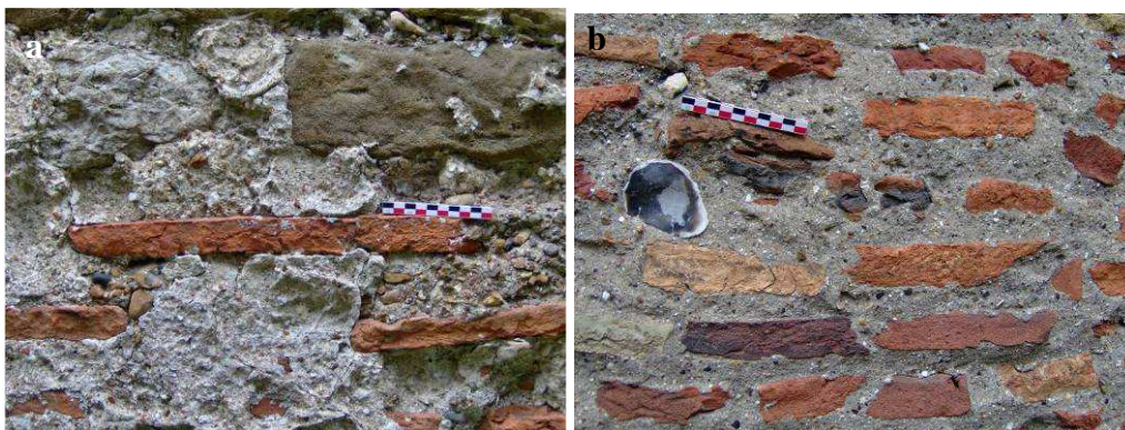
Figures 120 a & b : A gauche, brique aux dimensions allongées (36 cm de long et 3,5 cm d'épaisseur) (a) ; à droite, diversité des couleurs des briques du mur sud du chevet de Saint-Martin (b).
