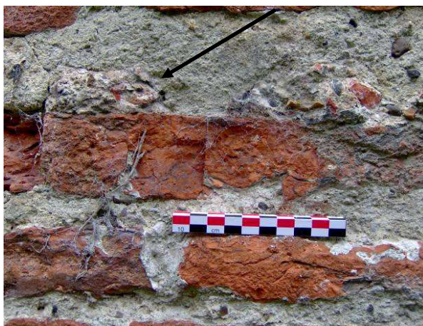
Figure 140 : morceau de mortier de tuileau adhérent à l'une des briques du chaînage d'angle nord-est.
