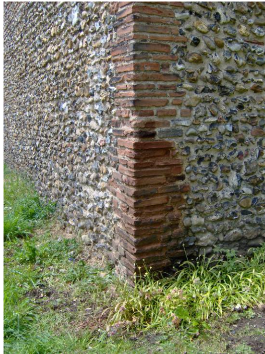
Figure 160 : Localisation du prélèvement 363-3 : chaînage d'angle sud-est du chevet.
