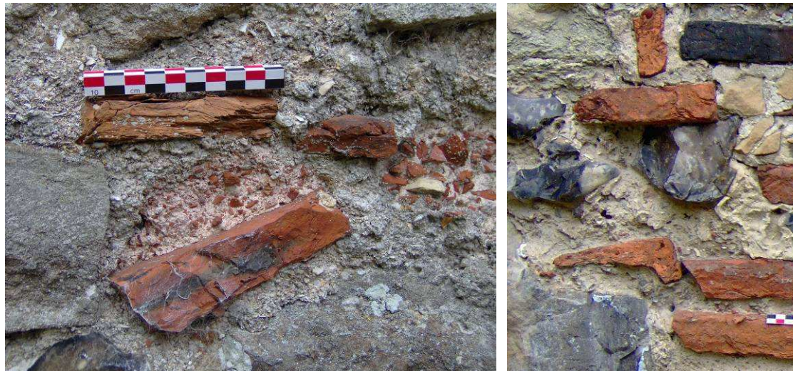
Figures 129 a & b : Présence de mortier de tuileau collé aux briques et fragment de tegula .
