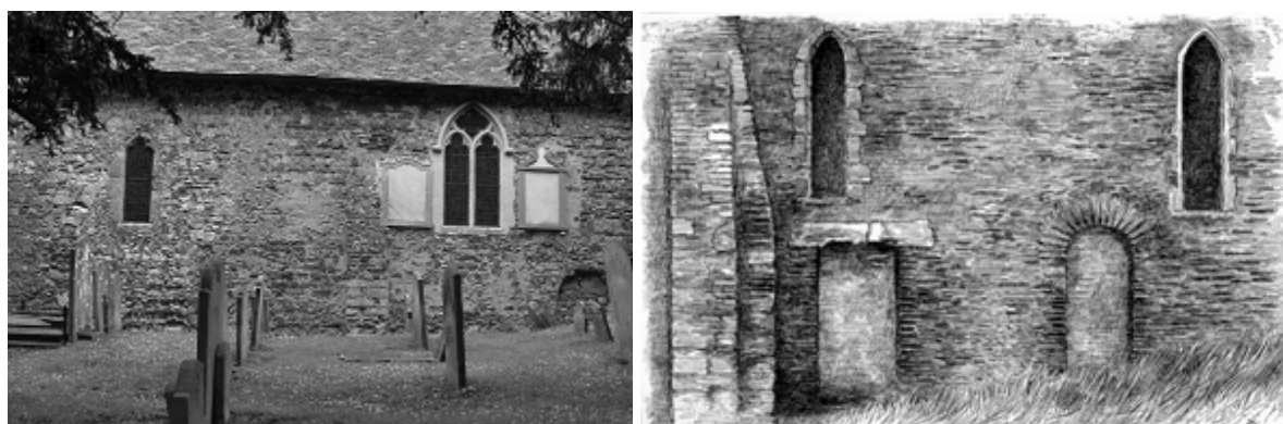
Figures 115 et 116: mur sud extérieur de la nef et partie occidentale du mur sud du chevet, d'après un dessin original de Mrs E.Parry (Routledge, 1891).
