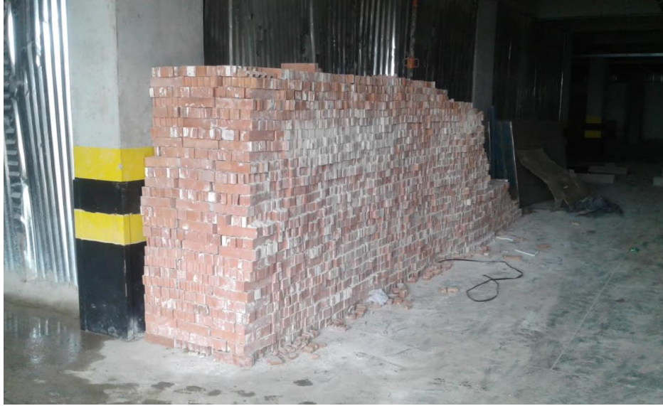
Tomadas por: Henry Cano. Acopio de material. Almacén de obra Universidad Externado, 2017
